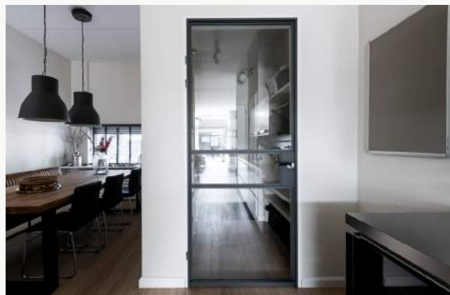
Vervanging standaard opdekdeur door GewoonGers opdekdeur, 2315mm hoog
