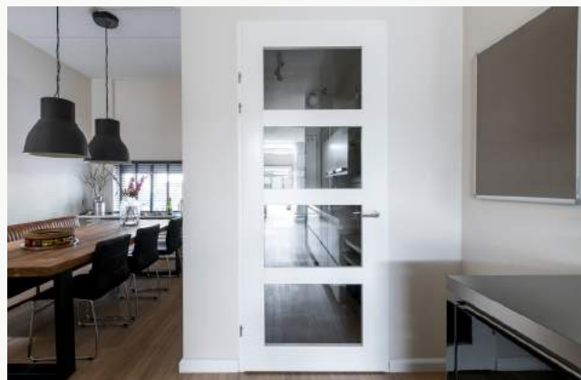
Bestaande situatie in een woning met standaard opdekkozijn, 2315mm hoog
