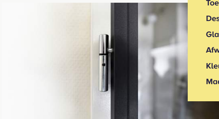
De deuren draaien op paumellescharnieren en kunnen naar één zijde worden geopend
